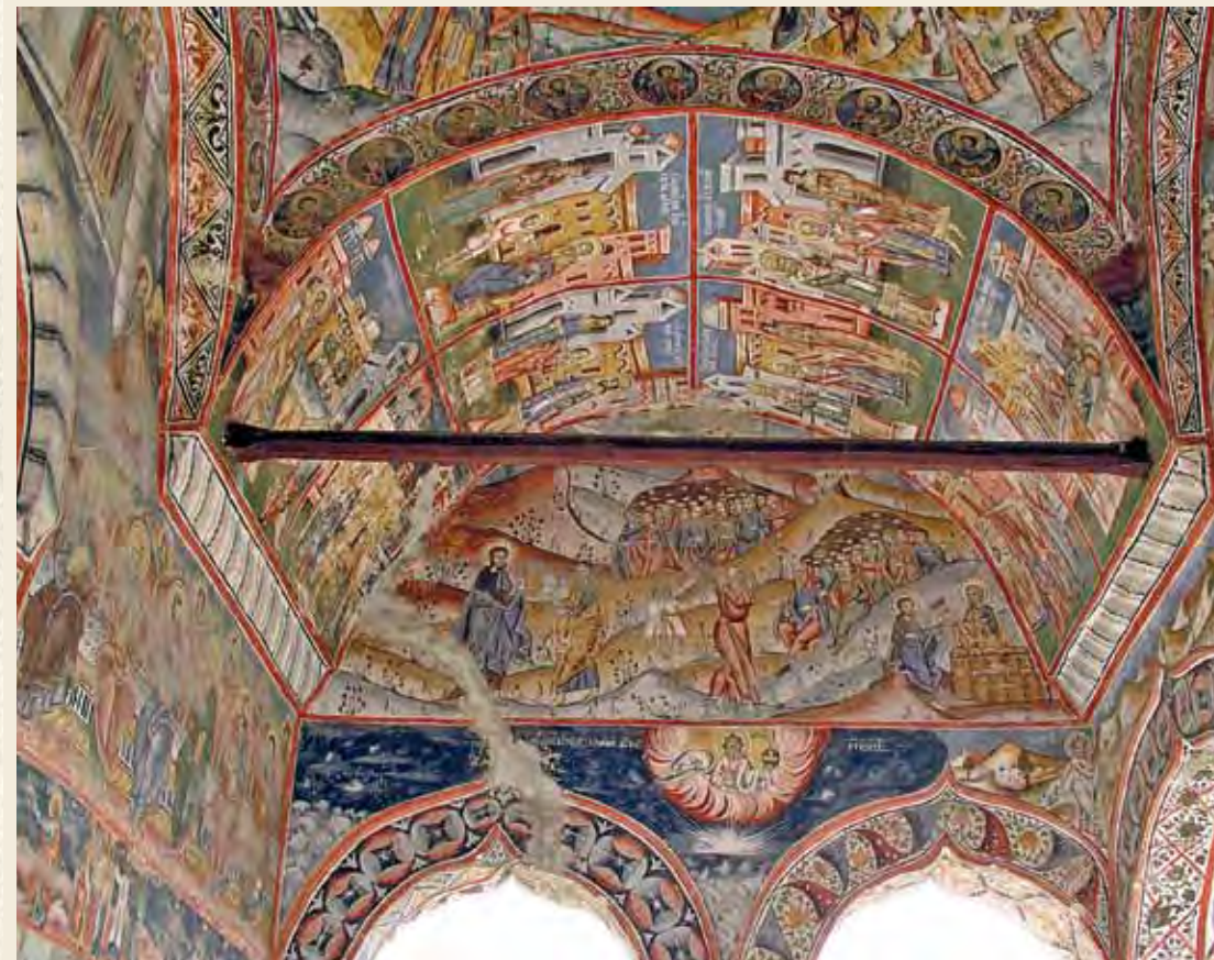
Pictură din pridvorul bisericii, latura de sud
