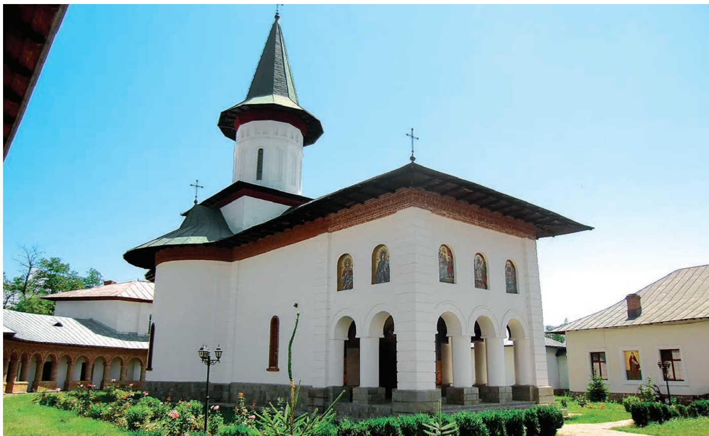
Corpurile de chillii, Casa Domnească și biserica Mănăstirii Glavacioc în urma restaurărilor din timpul stăpînei Protosinghelului Casian, desfășurate sub atenta îndrumare a Arhiepiscopului Calinic al Argeșului și Muscelului
