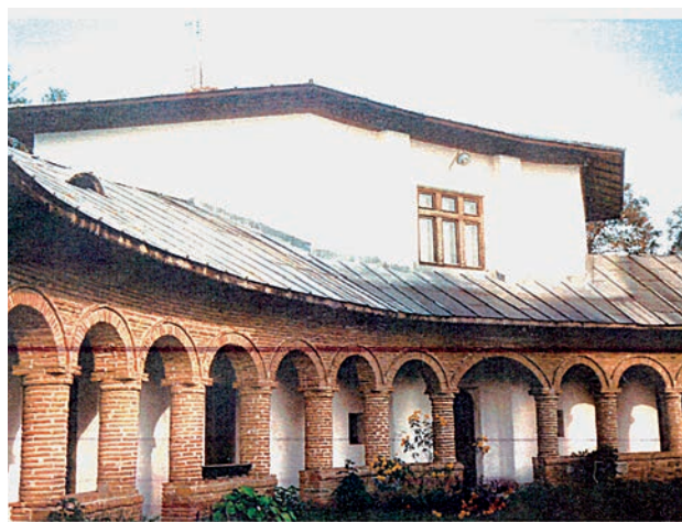
Stăreția, chiliile, alte clădiri anexe și casa domnească din incinta Mănăstirii Glavacioc
